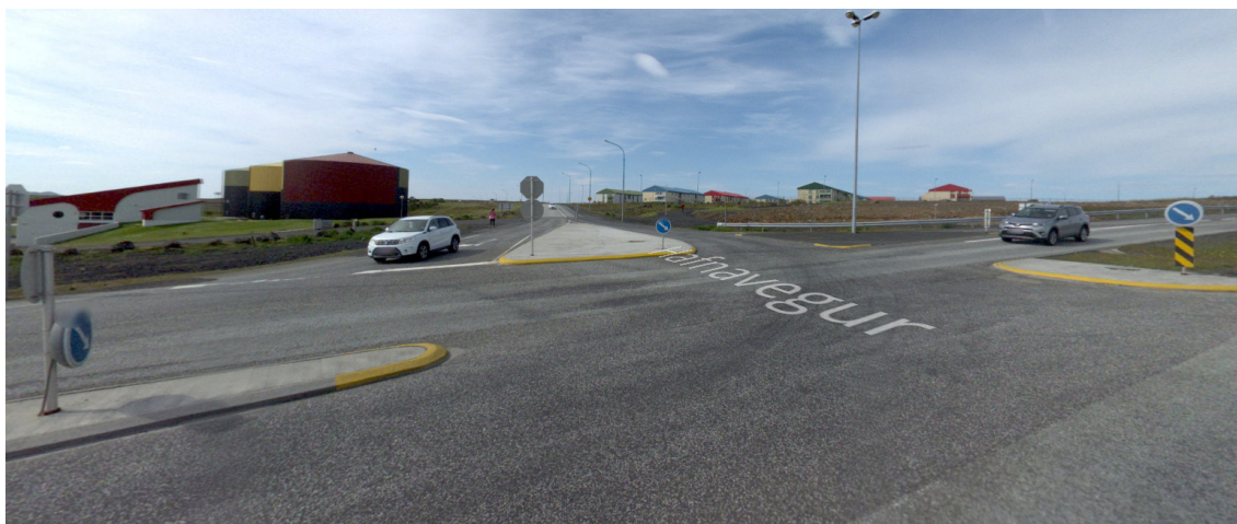
Mynd 5. Núverandi gatnamót Reykjanesbrautar og Hafnavegar, séð frá Reykjanesbraut (Já, 2018).
